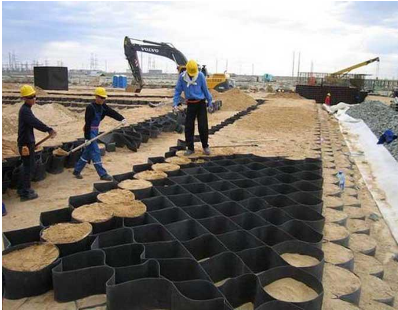
土工格栅施工现场图
